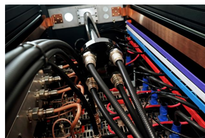
RED DE TOMA A TIERRA EN COBRE
